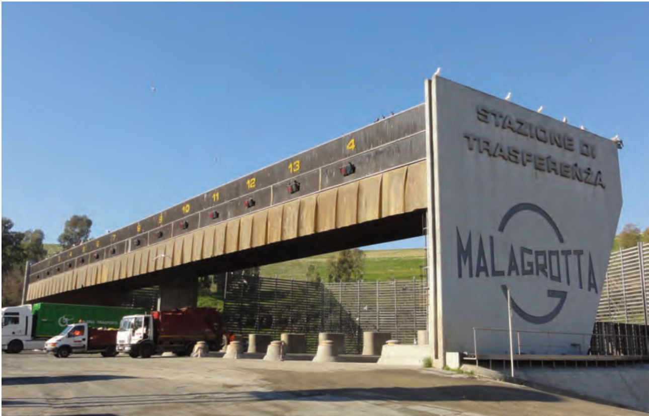
MALAGROTTA. STAZIONE DI TRASFERENZA.
