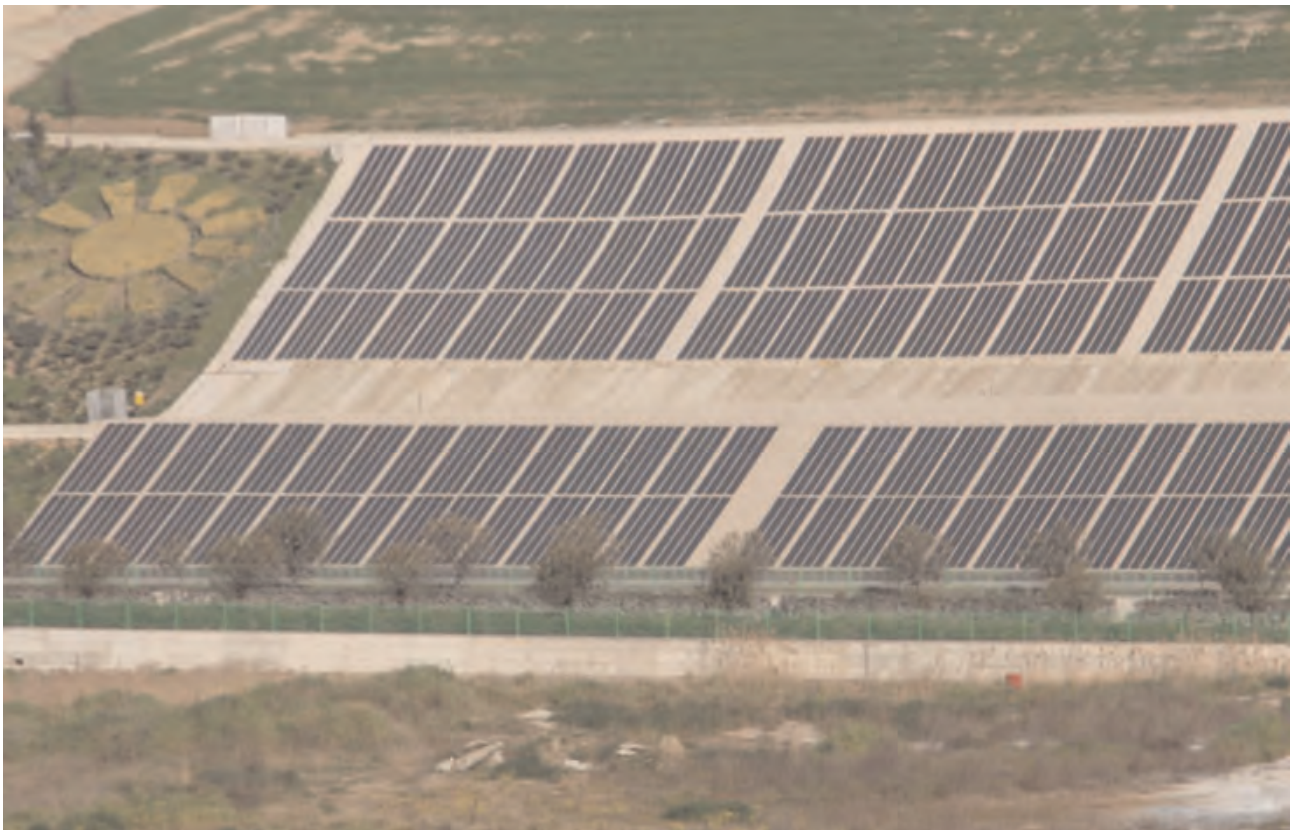
MALAGROTTA. CAMPO FOTOVOLTAICO.
