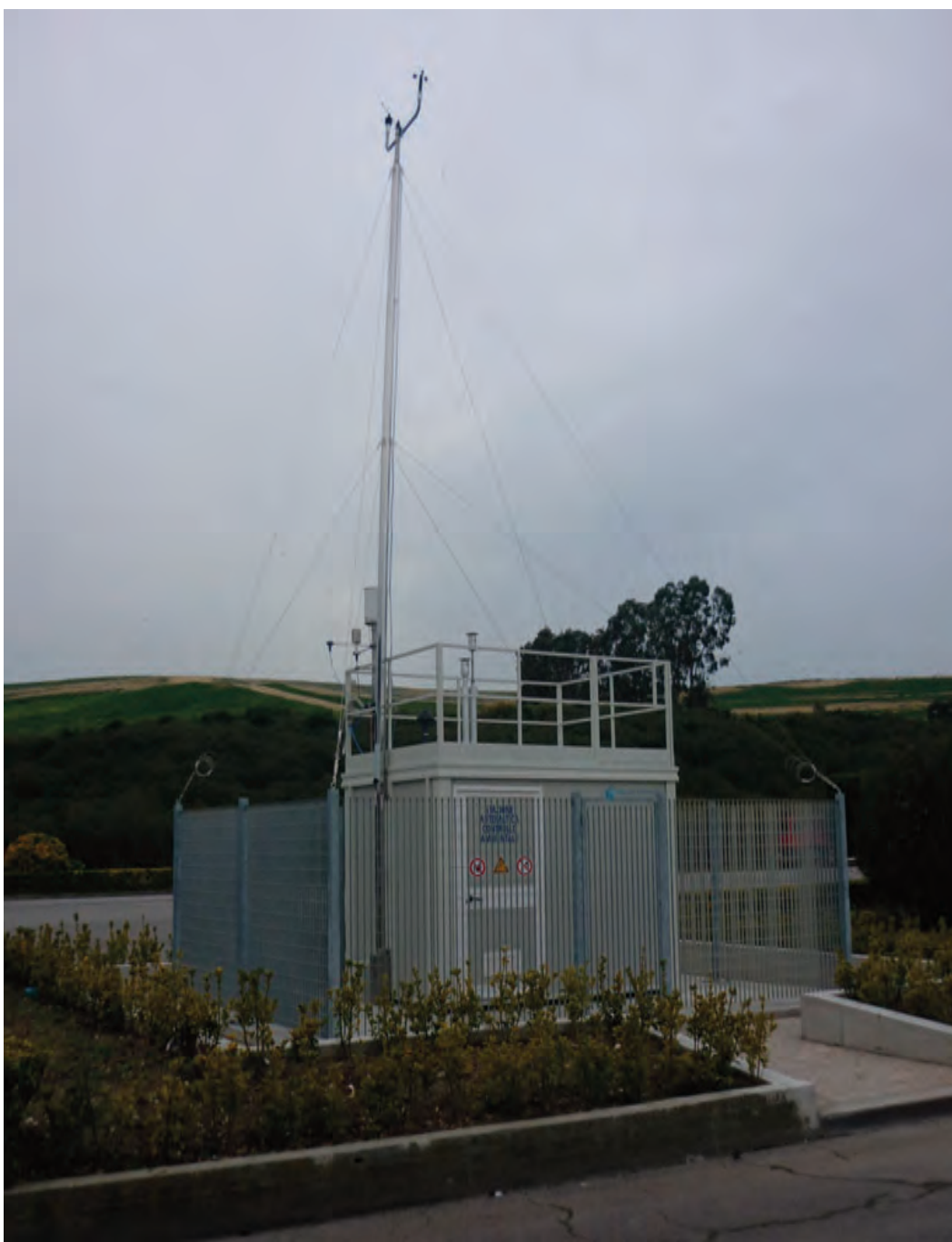
MALAGROTTA. STAZIONE AUTOMATICA DI CONTROLLO AMBIENTALE.
