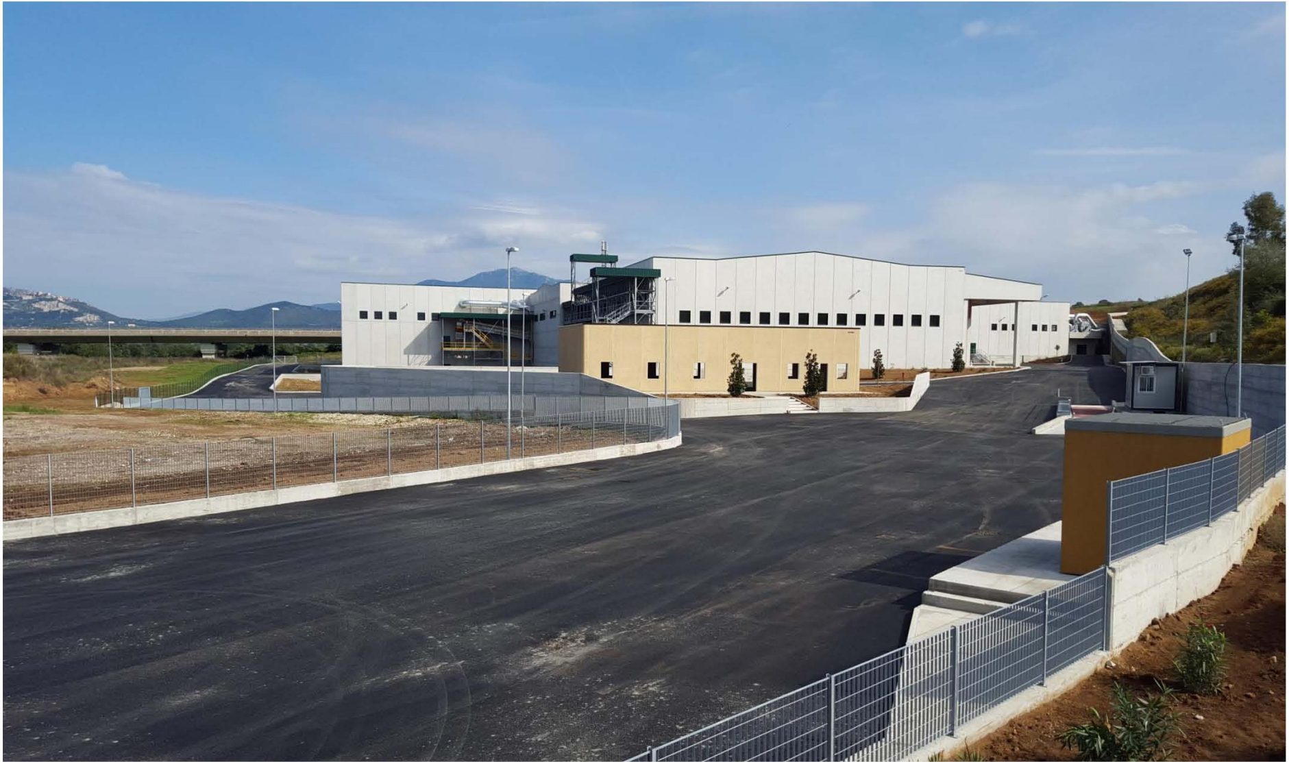
IMPIANTO TMB PRONTO PER ENTRARE IN ESERCIZIO (autorizzato con AIA n. C1869 del 2/8/2010)
