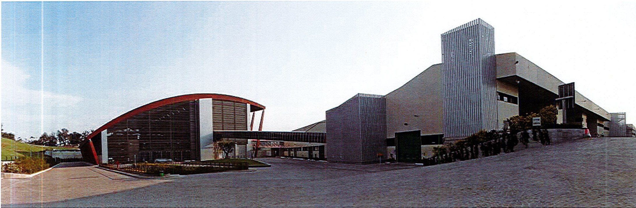
Centrale di Gassificazione di Malagrotta
